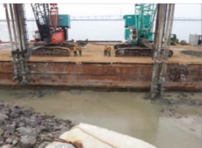
인천항 국제여객부두 1단계 건설공사 중 호안기초
